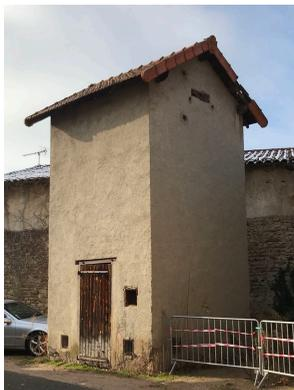
La toiture de l'ancien transformateur rue de la Ruelle est en mauvais état. Plusieurs tuiles sont tombées. Son pourtour a été sécurisé. La démolition envisagée dans un premier temps, trop coûteuse et posant trop de problèmes techniques, fera place à une simple réfection partielle de la toiture.
